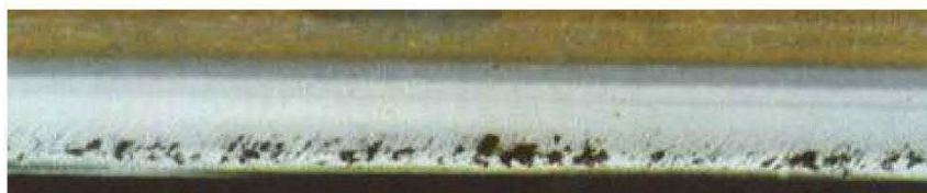
Obr. 5.31 Kolejnice – vada head check
