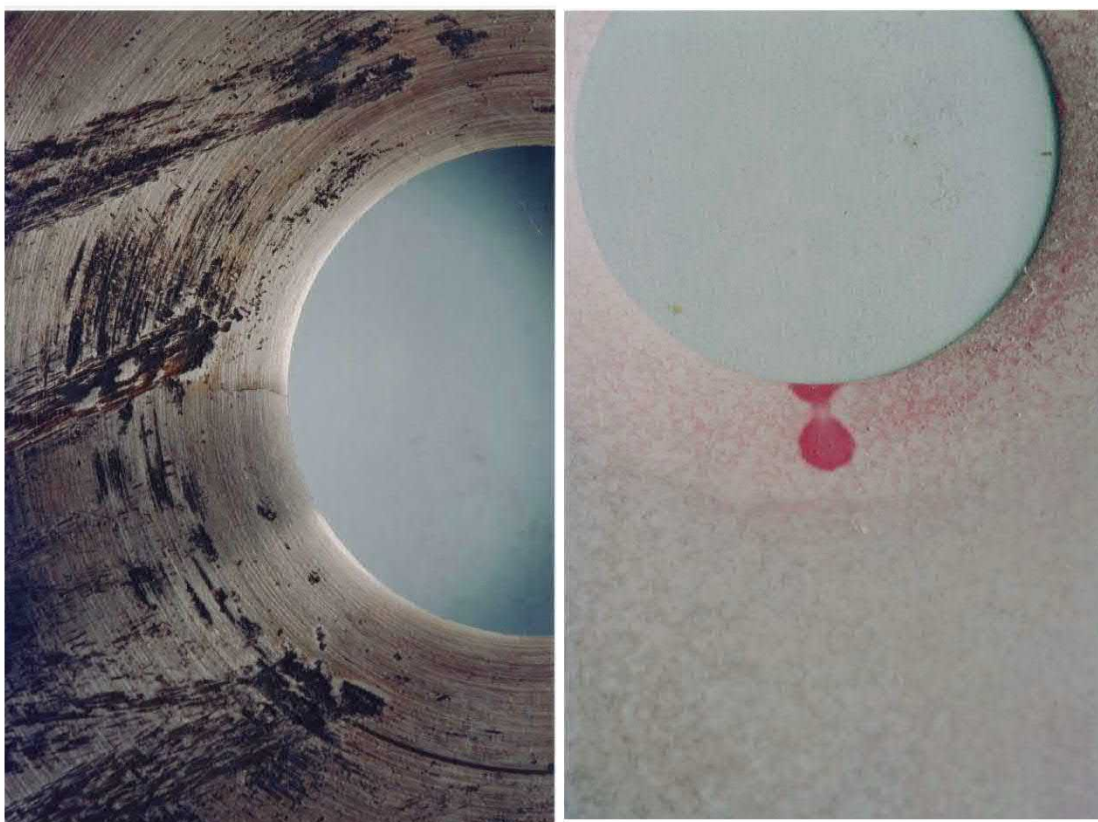
Obr. 8.32 Přední a zadní plocha v oblasti trhlinky
