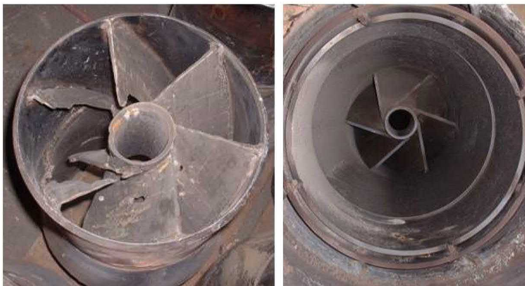
Obr. 1.11 Degradovaná součást po opotřebení pevnými částicemi nesenými plyným médiem a součást po uvedení do provozu (vpravo)
