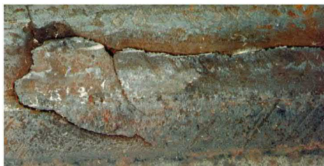
Obr. 5.29 Kolejnice – odlupování materiálu
